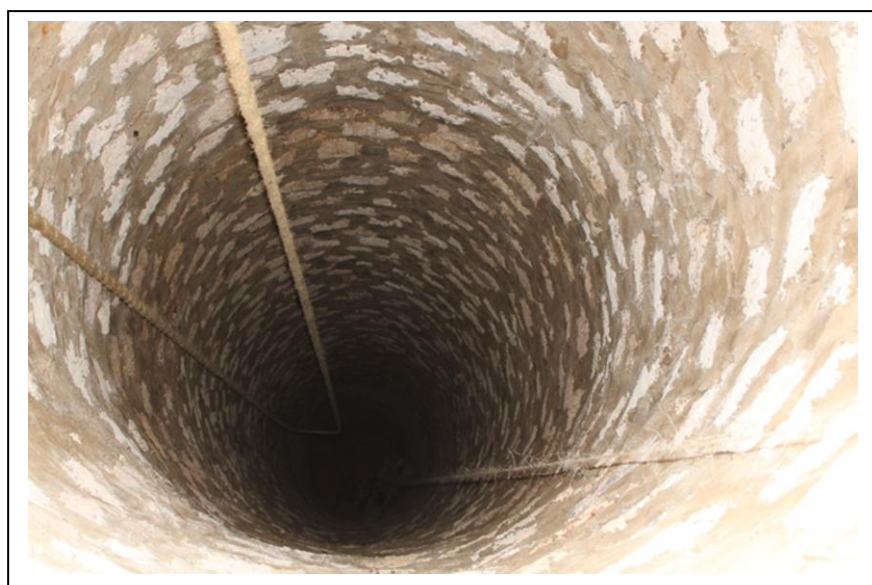
Waterput in aanbouw
